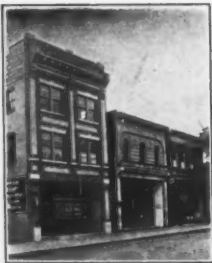
Home Office 525-7-9 N. 2nd St., Richmond, Va.
